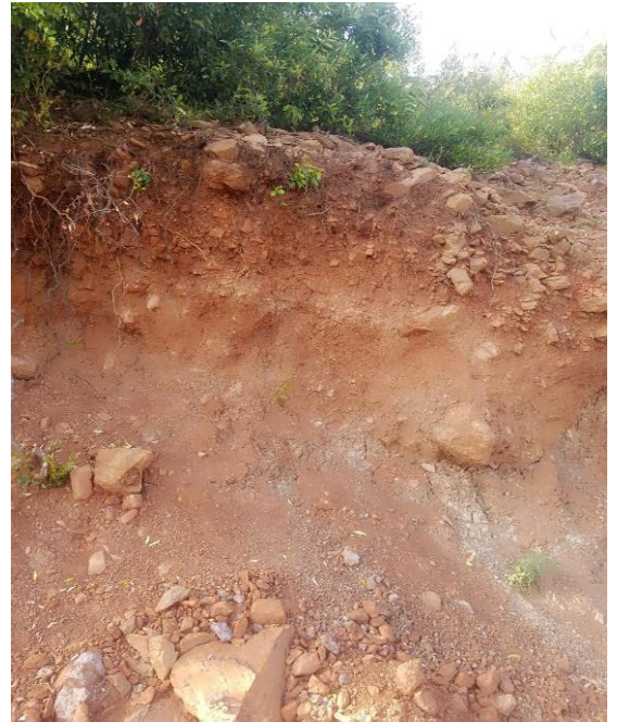
b) Actual Site Photo
