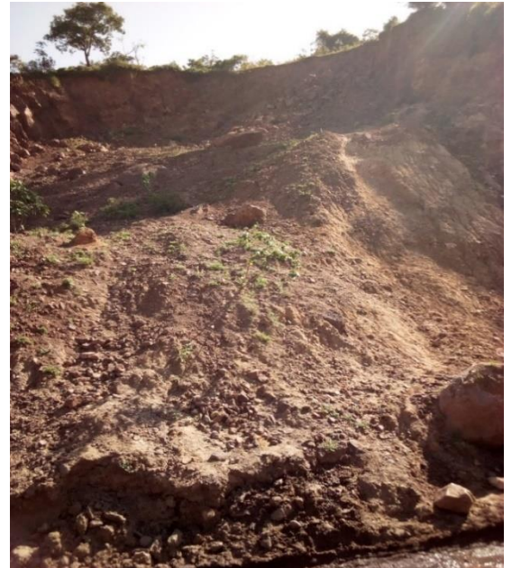
b) Actual Site Photo
