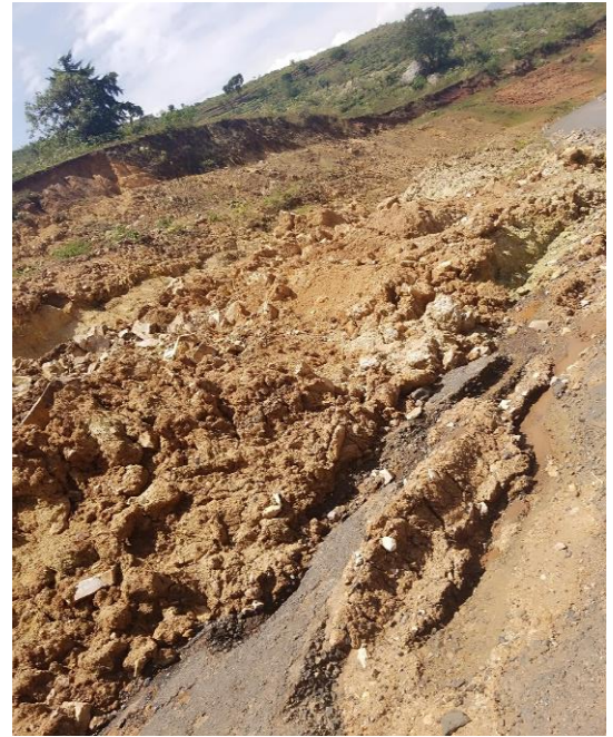
b) Actual Site Photo
