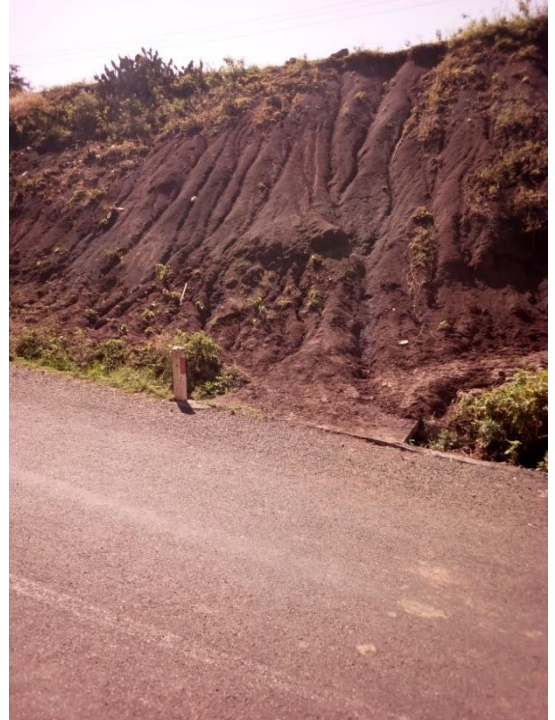
b) Actual Site Photo
